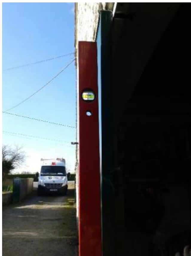
Figure 5b – Observation d'un effet bilame sur volet battant
